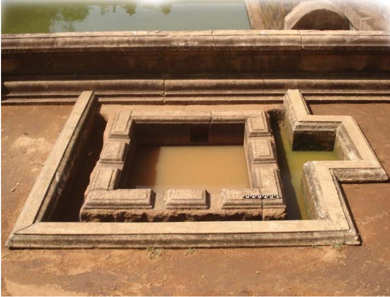
உரு 1.12 குட்டம் பொய்கையின் நீர் வடிகட்டி (வெளிப்பகுதிக்குள் வந்து சேரும் நீர் உட்பகுதியில் அமைக்கப்பட்டுள்ள சுவரில் காணப்படும் 6 சிறிய வழிகளினூடாக மத்திய பகுதிக்குள் சென்று அங்கிருந்து ஒரு குழாய் மூலம் பொய்கைக்குச் செல்கிறது.)
