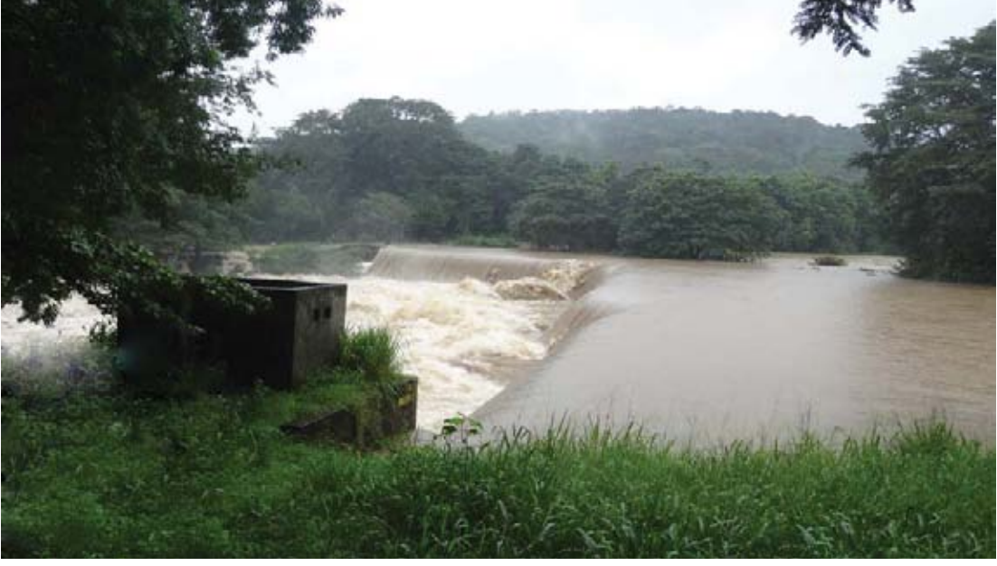
உரு 1.9 எலஹர அணைக்கட்டு
